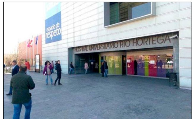
HOSPITAL RÍO HORTEGA (VALLADOLID)
